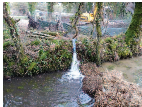
Photo 36 - Filtre à paille sur un chantier de pose de canalisation de gaz (Source ALTHIS)
